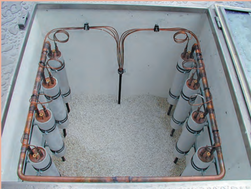
Abb. 1.14: CO 2 -Schacht (Foto: Heliotherm Wärmepumpentechnik GmbH)
