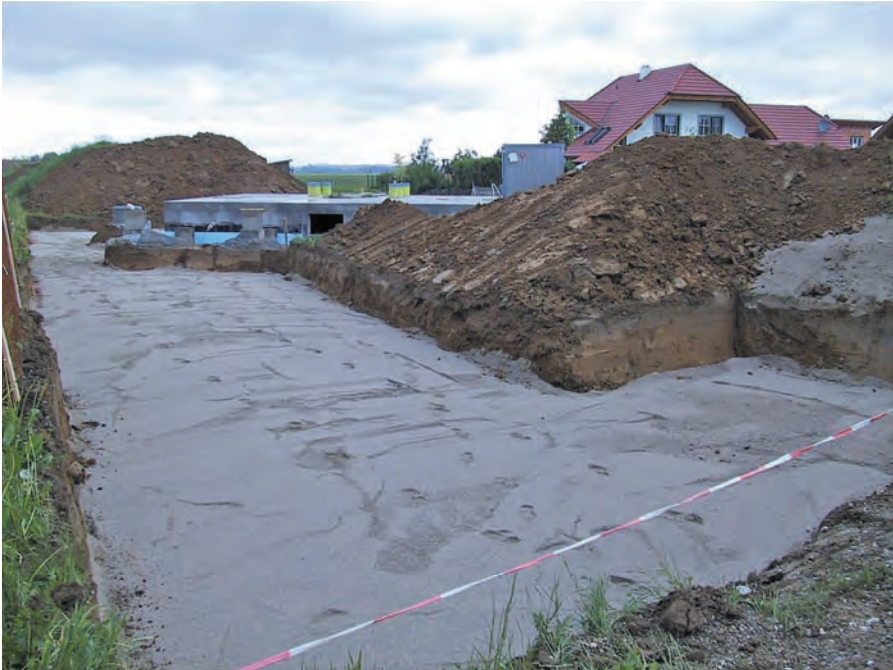
Abb. 3.9: Baugrube beachtlichen Ausmaßes, vorbereitet zum Verlegen eines Erdwärmekollektors
